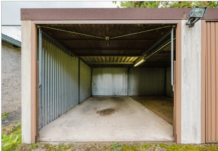
Doppelgarage mit Strom und Licht
